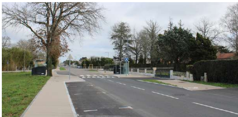
TRAVAUX DE VOIRIE SUR L'AVENUE ARTHUS-PRINCÉ
