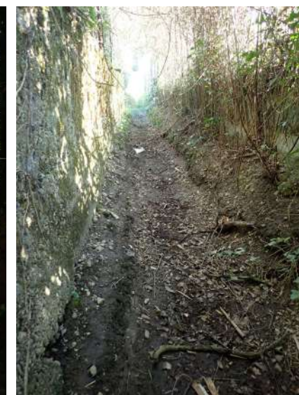
Vue depuis la buse aval vers le coude 90°
