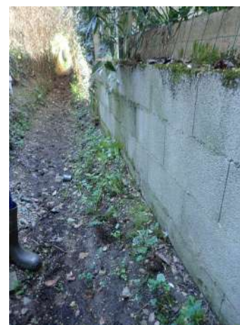
Le mur restauré en RD après le coude
