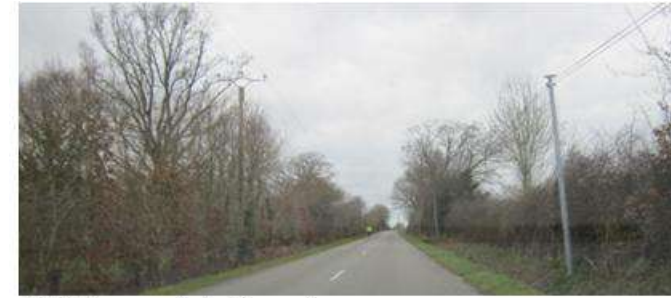
RD 6 au nord de Chauvé
