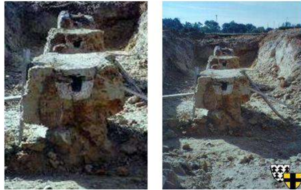
Ce cliché a été pris lors des travaux de la déviation de la D751.
